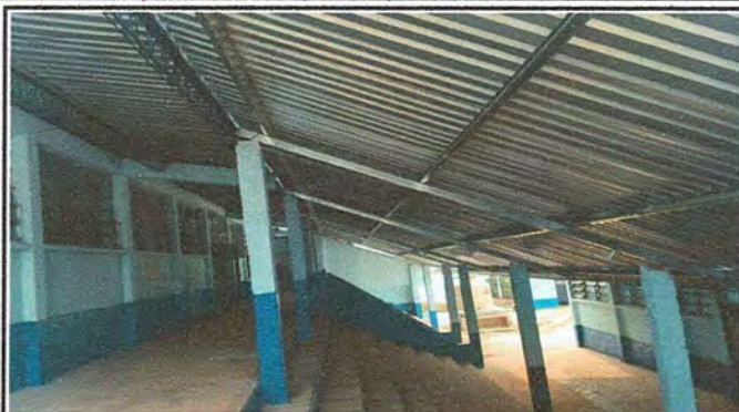
Foto 2: Panorámica corredor de escuela trabajos finalizados.
