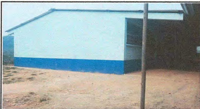
Foto1: Panorámica modulo I (trabajos finalizados).
