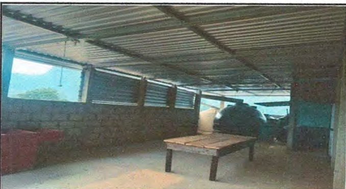
Foto 3: Panorámica de área de cocina ya rehabilitada. Instalación de tubería agua fluvial, cambio de depósito de agua, cambio de piso de concreto.
